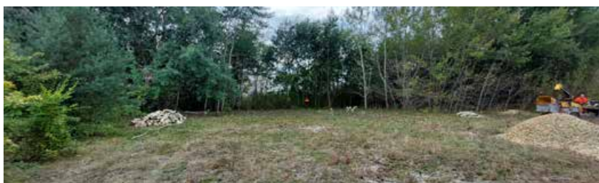
Beginn der Bauarbeiten am Seelhausener See
